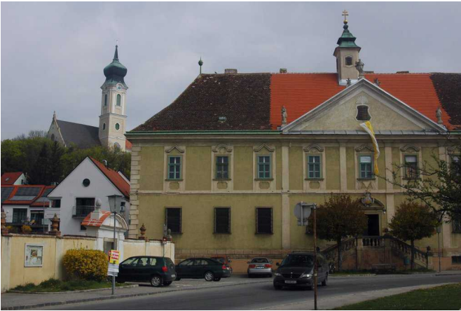
Fig.1a: Mistelbach, ehem. Barnabitenkloster, Südwesttrakt
